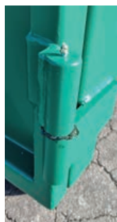
Panti s podmazivanjem
