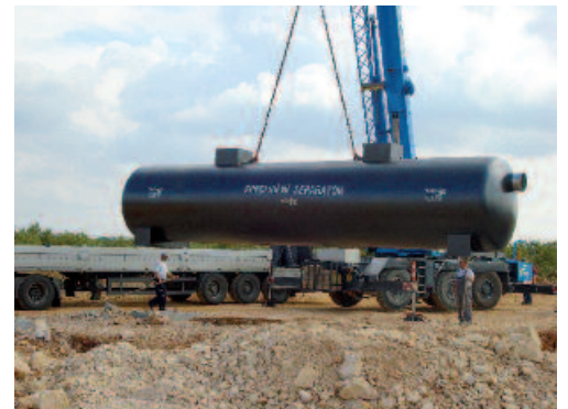
Montaža specijalnog separatora tip TEHNIX
