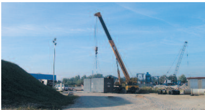
Istovar i ugradnja separatora Tehnix
