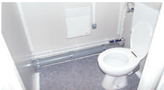
Izvedba vodovodnih instalacija sa Wavin sistemom cijevi
