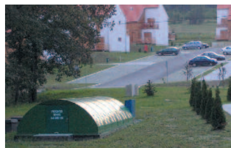
Biorotor Tehnix ugrađen uz apartmansko naselje
