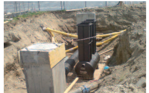
Ugradnja specijalnog separatora
