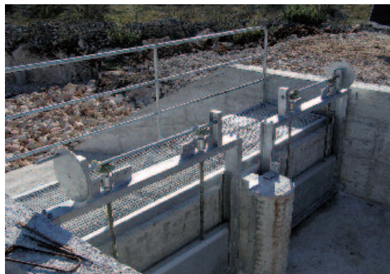
Prikaz ugrađenih zapornica na lokaciji
