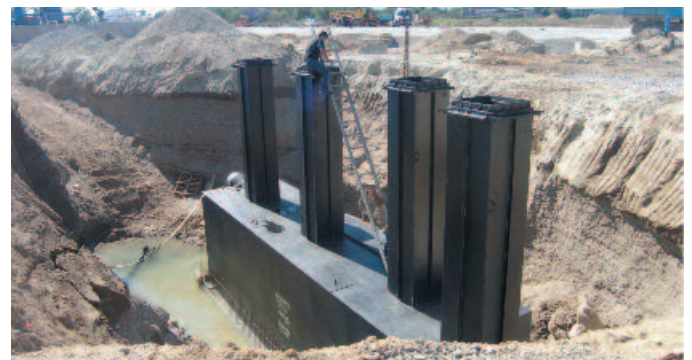
Primjer ugradnje separatora
