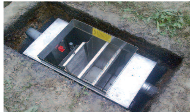
Prikaz ugradnje mastolova
