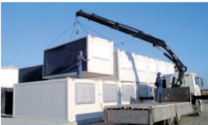
Montaža kontejnorskog naselja na lokaciji
