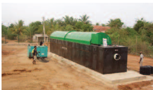
Montaža BRT-1500 u Sri Lanki
