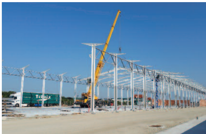
Montaža metalne konstrukcije
