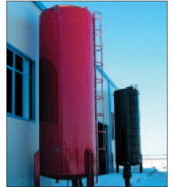
Vertikalni spremnici prema DIN 6618
