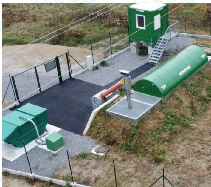
Ugradnja vertikalnog pužnog separatora na ulaz u biorotor
