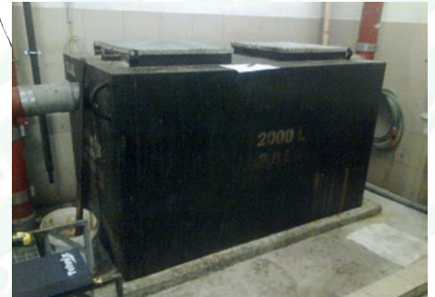
Mastolovi za nadzemnu ugradnju + mogućnost nadogradnje prepumpne stanice
