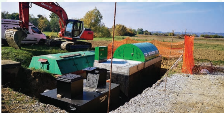
Zamjena uređaja staro za novo - kanalizacija je cijelo vrijeme bila u funkciji, trajanje radova sedam dana
