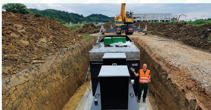
Nadzor i kontrola ugradnje uređaja
