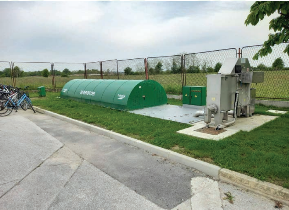
INOX biorotor s automatskim mehaničkim izvlačačem tkanina
