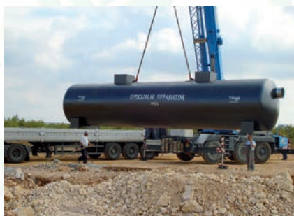
Prikaz ugradnje specijalnih separatora na terenu
