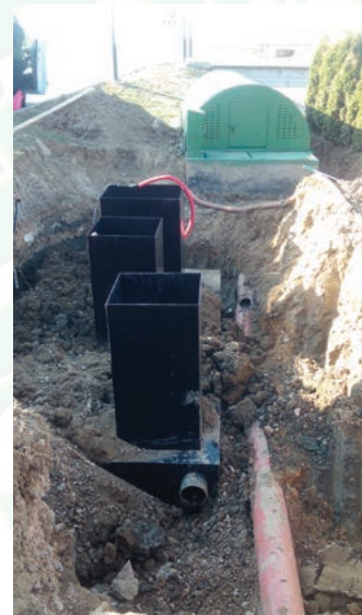
Ugradnja prihvatne komore na postojeći kanalizacijski sustav
