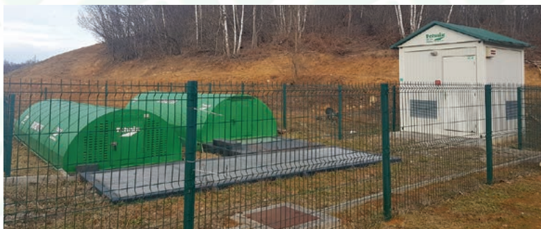
Nadogradnja nove biorotorske jedinice uz postojeći uređaj
