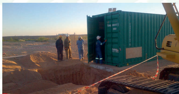
Montaža kontejnerskog biorotora u radničkom kampu u Iraku
