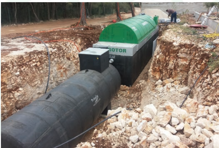
Ugradnja biorotora u raznim uvjetima za vaše domove, stambena naselja, turistička naselja i gospodarske objekte
