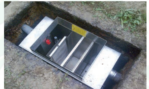
Prikaz ugradnje mastolova
