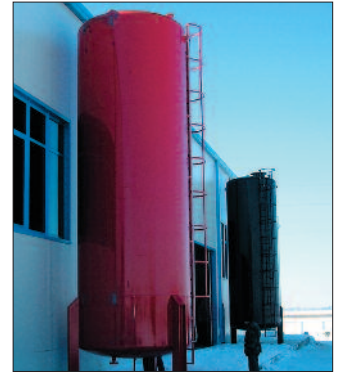
Vertikalni spremnici prema DIN 6618
