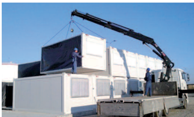
Montaža kontejnorskog naselja na lokaciji
