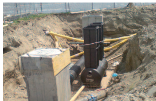
Ugradnja specijalnog separatora
