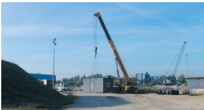
Istovar i ugradnja separatora Tehnix
