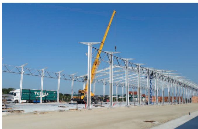
Montaža metalne konstrukcije
