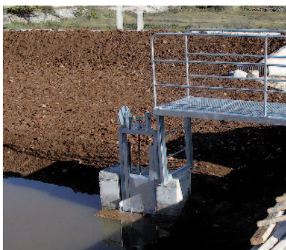
Podizanje specijalnog separatora pomoću dizalice na lokaciji
