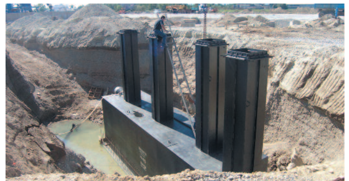
Primjer ugradnje separatora
