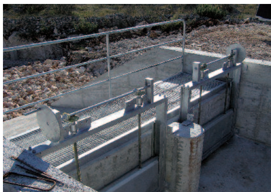
Prikaz ugrađenih zapornica na lokaciji
