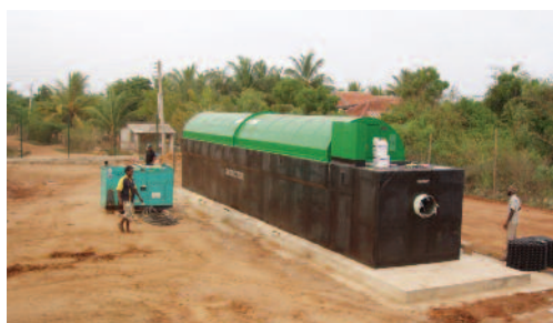
Montaža BRT-1500 u Sri Lanki
