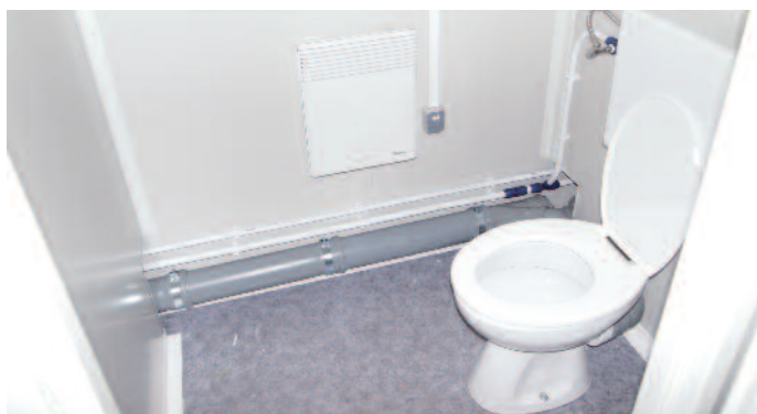
Izvedba vodovodnih instalacija sa Wavin sistemom cijevi
