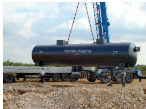
Montaža specijalnog separatora tip TEHNIX
