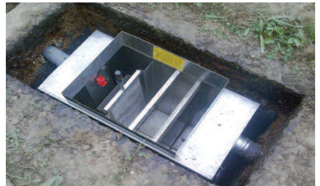
Prikaz ugradnje mastolova
